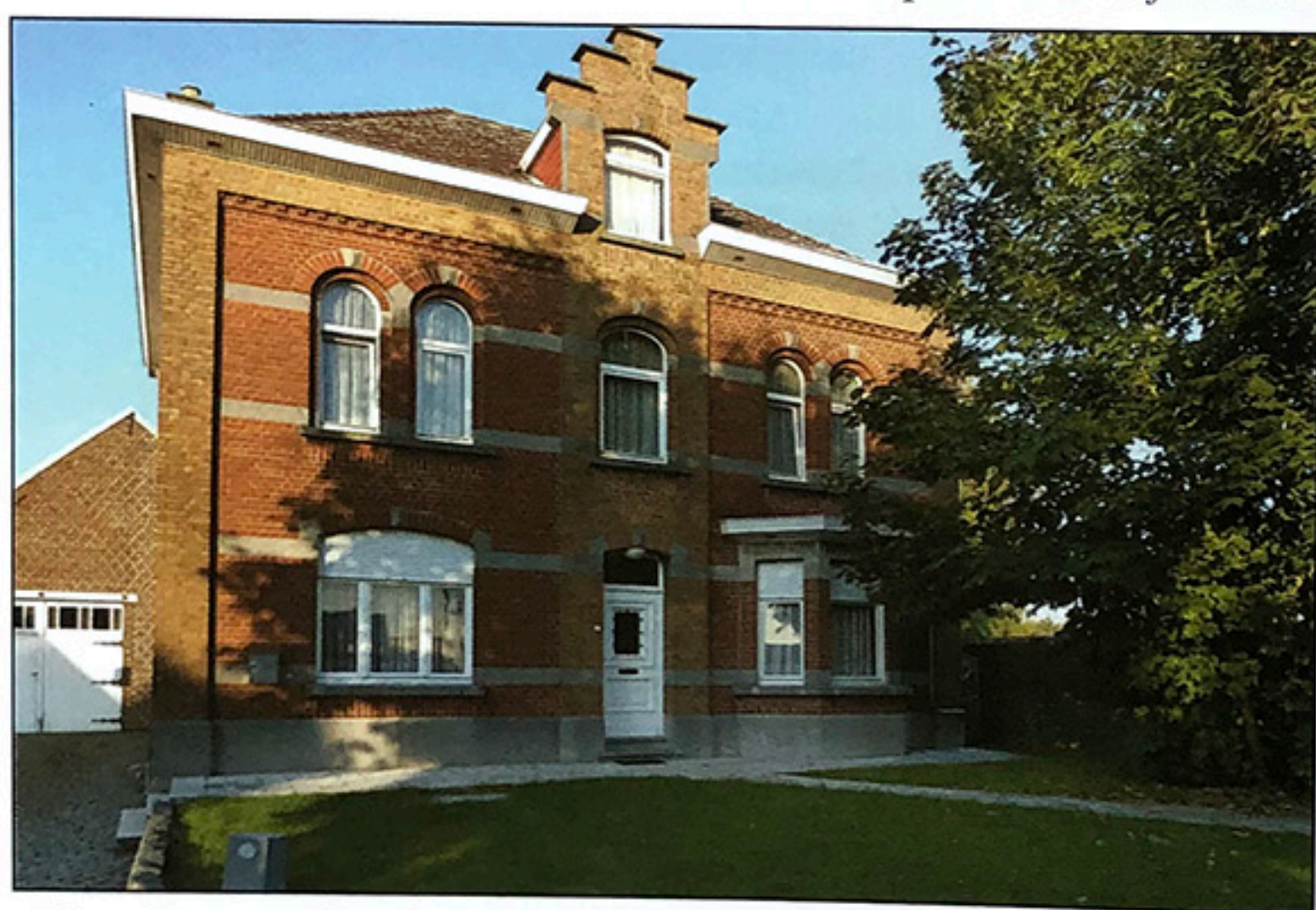
Nieuwbouw in de Turkeyestraat. (naast de trambaan).
